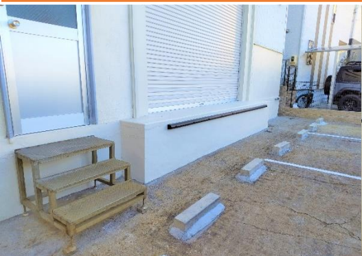
スロープ設置前
