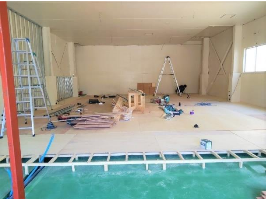
床の高さ上げ
