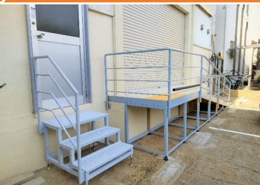
スロープ設置
