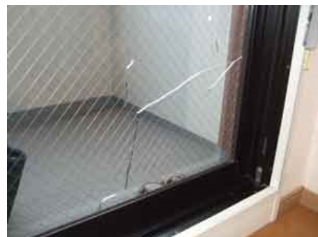
熱割れしたガラス
